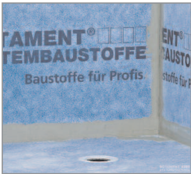
A falszigetelés hozzáigazítása gyárilag szigetelt padlóelemhez a BOTACT Szigetelő lemez rendszerrel történik.
